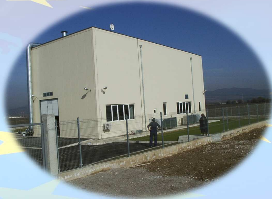
Помпена станция Нови Искър
